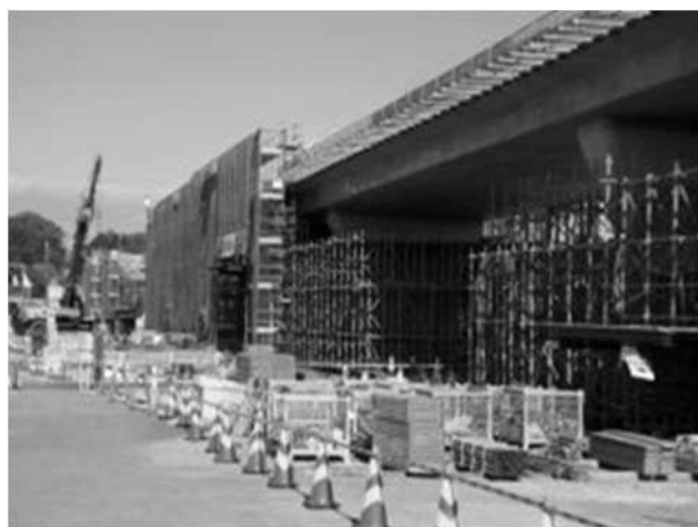
写真-8 別宮第 3 高架橋の施工状況
