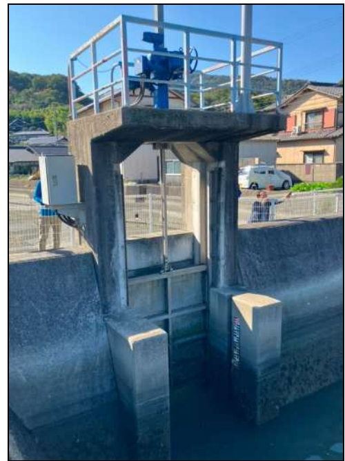
写真-6 西側水門(下流側より撮影)
