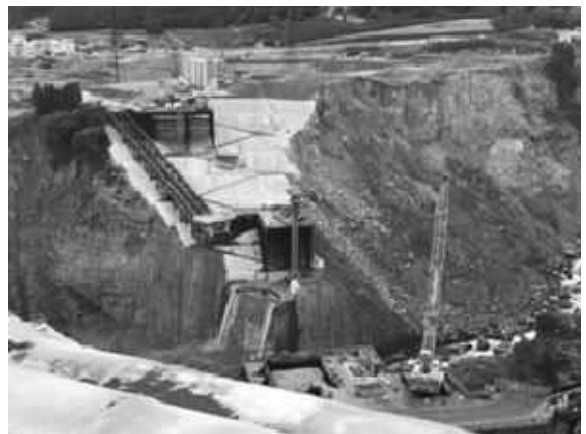
写真-26 阿蘇大橋の建設状況(2018.10.26)
