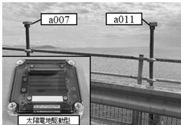
図-8 傾斜計および設置状況
