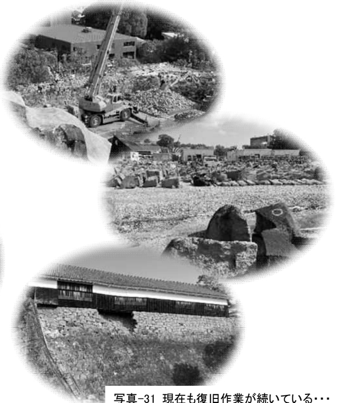
写真-31 現在も復旧作業が続いている...
