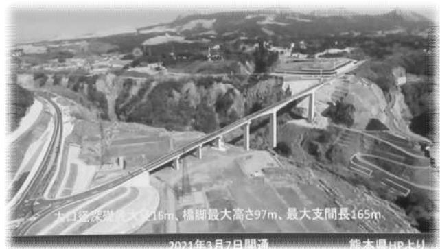
写真-27 新阿蘇大橋_2021.3.7 開通
