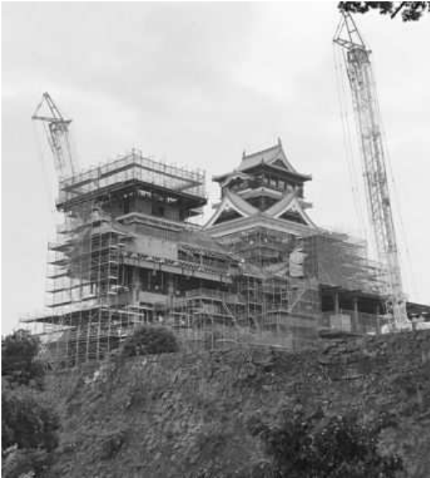
写真-28 復旧作業が進む天守閣(2018.10.26 撮影)
