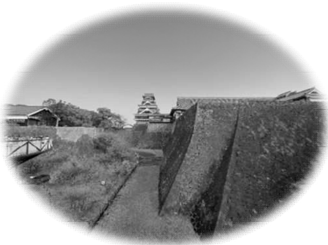
写真-30 特別見学通路から望む 天守閣、本丸御殿、二様の石垣
