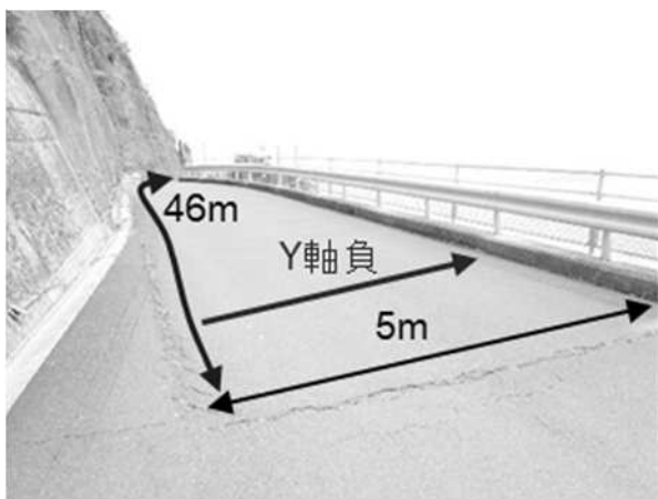
図-7 観測対象の構造物と道路上に現れた変状
