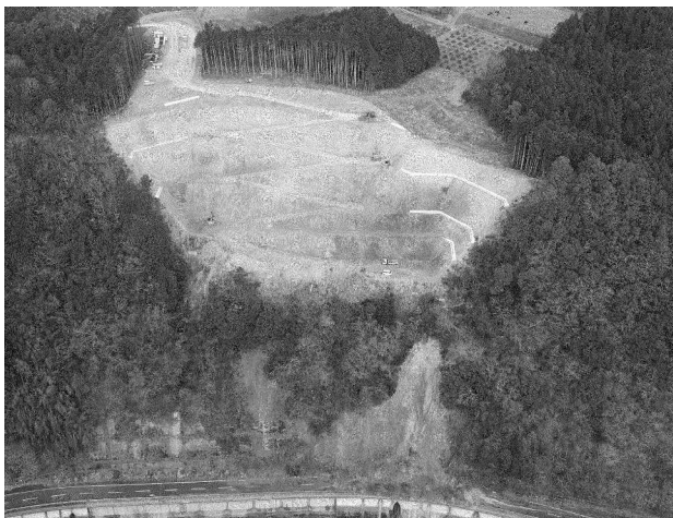
写真-3 排土工完成状況
