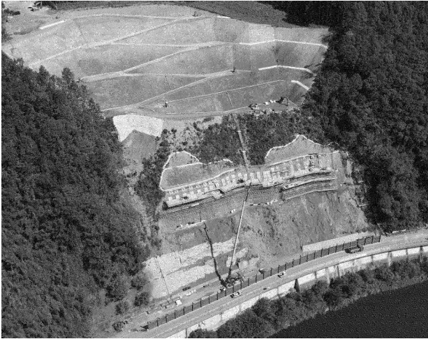
写真-5 片側交互通行による交通開放
