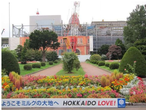
写真-7 札幌・旧道庁(修復中)
