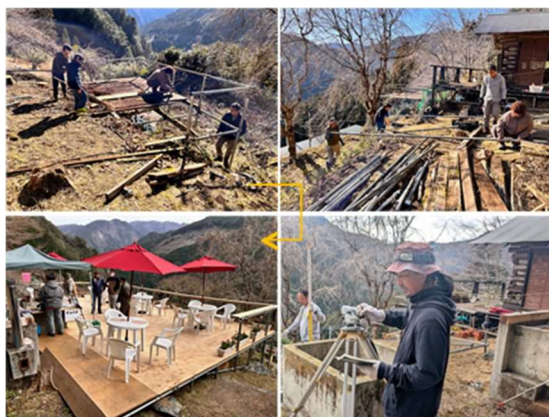
写真-8 展望デッキの解体・撤去、新デッキ完成までの様子
