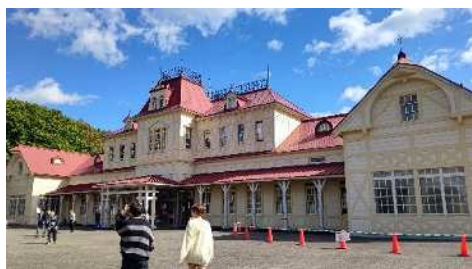
写真-15 旧札幌停車場
