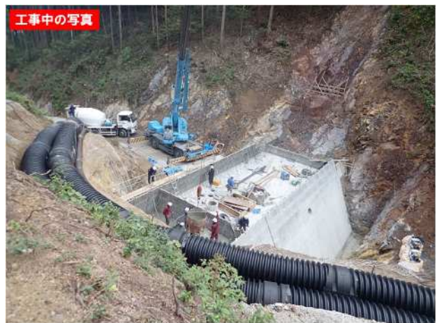
写真-1 工事中の砂防堰堤
