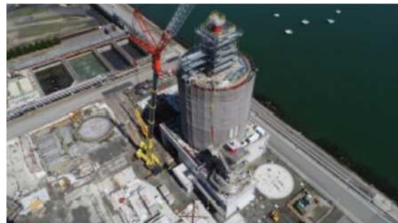
写真-7 サイロ上部機器据付状況
