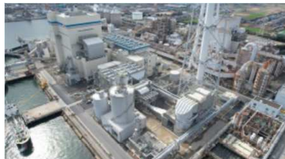
写真-8 据付完了
