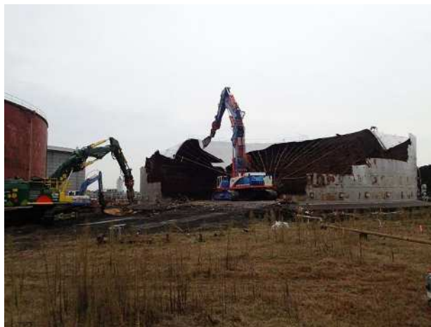
写真-3 重油タンク撤去状況その1
