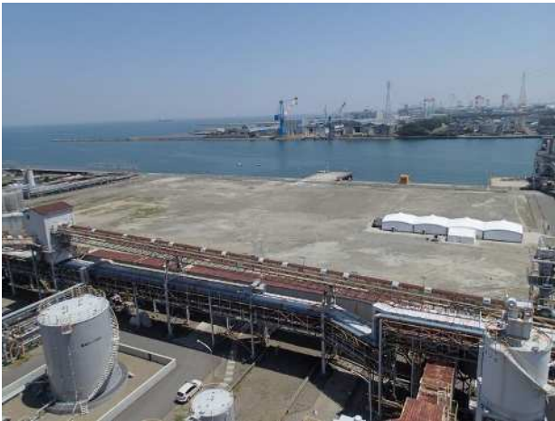
写真-5 燃料タンクヤード設備撤去後(起工式前)
