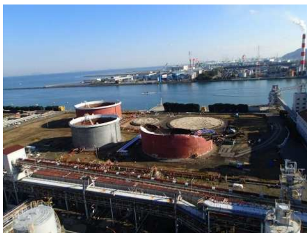
写真-4 重油タンク撤去状況その2
