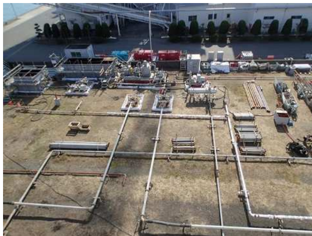
写真-2 温水洗浄装置、重油移送配管設置状況
