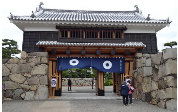
写真-9 令和4年に復元した桜御門
