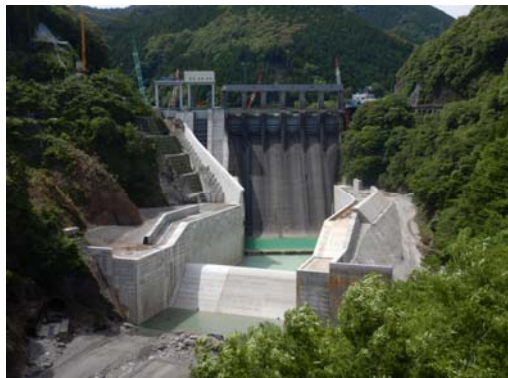
写真-1 長安ロダム全景(国土交通省 四国地方整備局 那賀川河川事務所 HP より)
