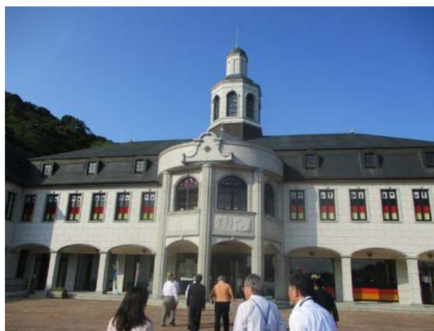
写真 4 鳴門ドイツ館の外観
