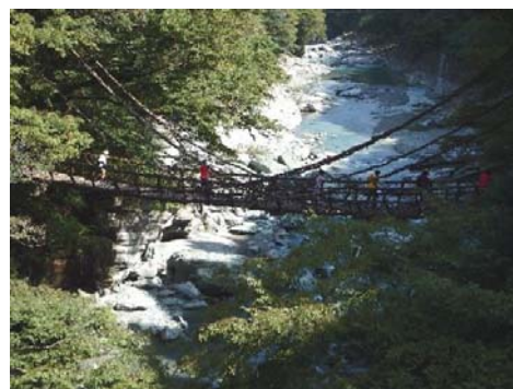
写真-2 かずら橋全景(下流側より)
