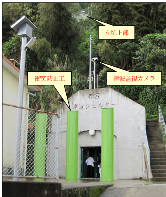
写真-2 津波避難シェルター出入口
