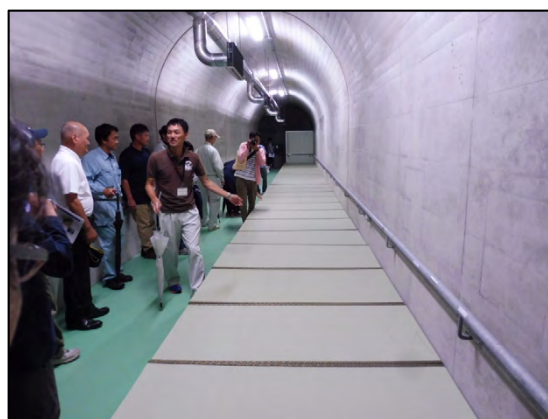
写真-5 シェルター内部状況
