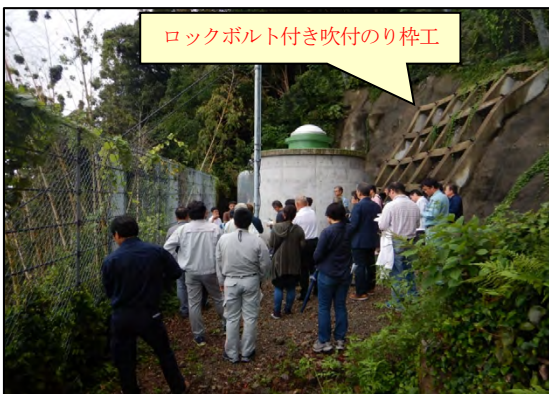
写真-9 立坑上部出入口部周辺
