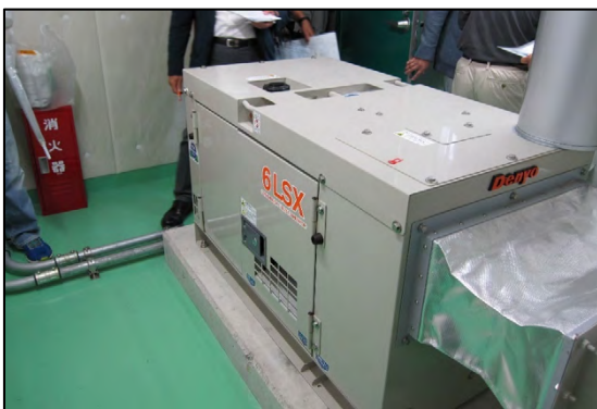
写真-8 非常用発電設備
