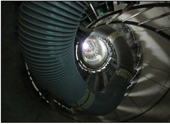
写真-7 立坑内部の螺旋階段(下方から望む)
