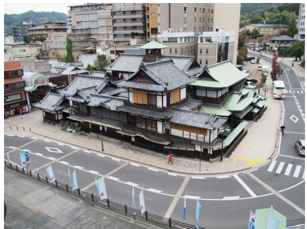
来年度改修予定の道後温泉本館
